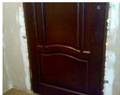
Появление на рынке монтажной пены существенно упростило установку дверных коробок. Но только правильное заполнение щели между коробкой и стеной монтажной пеной гарантирует блестящий результат. А чрезмерное заполнение щели пеной приведет к плачевным последствиям – дверная коробка искривится. Поэтому давайте разберемся, как задуть пеной щель между дверной коробкой и стеной.
