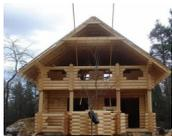
Ручной способ возведения сруба дает возможность получить дома высокого качества. Это делают посредством обработки топором и иными инструментами. Благодаря чему сохраняется верхний слой древесины, что гарантирует долговечность бревна.
